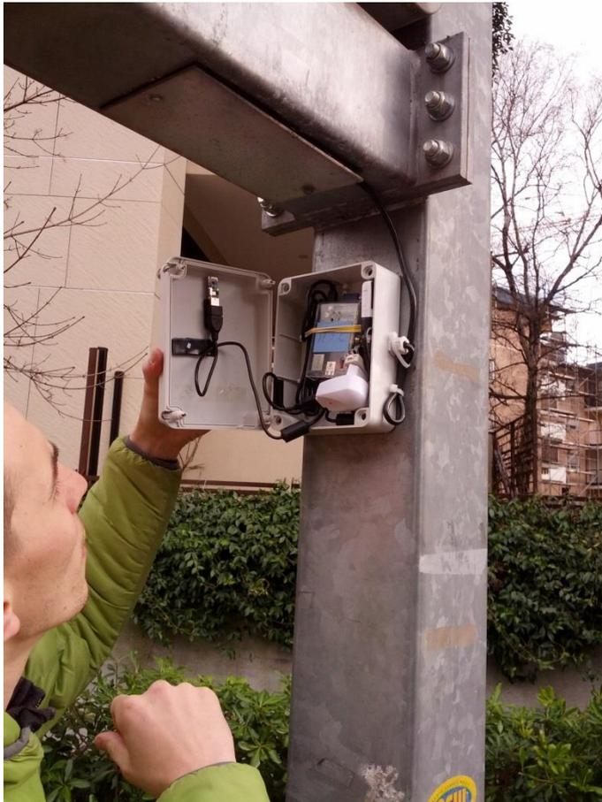
Figura 4: Uno dei detector Bluetooth installati nelle strade di Bolzano.
